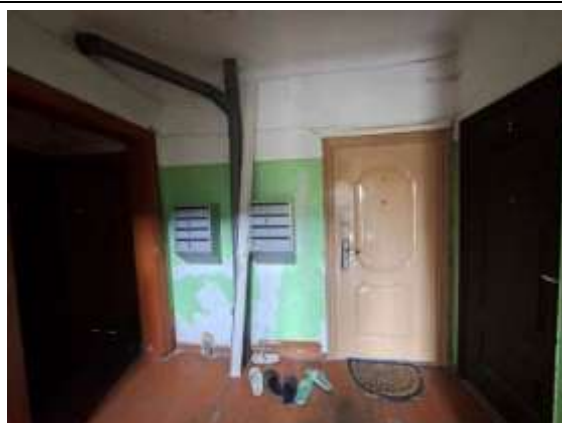
1.stāva kāpņu telpa
