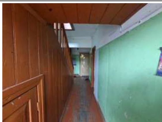
1.stāva kāpņu telpa
