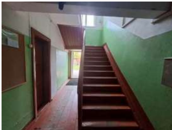
1.stāva kāpņu telpa
